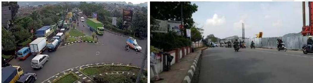
Gambar 4. 42 Proses Pembangunan Double Track Jembaran Leuwigajah
