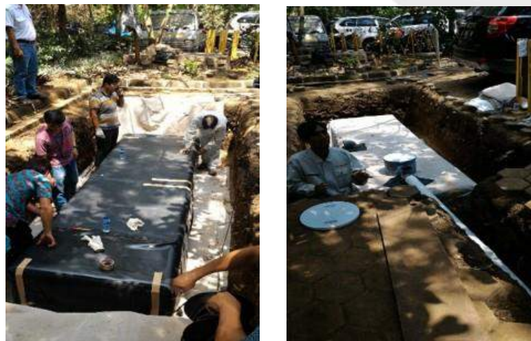
Gambar 4. 38 Pemasangan Sumur Resapan
