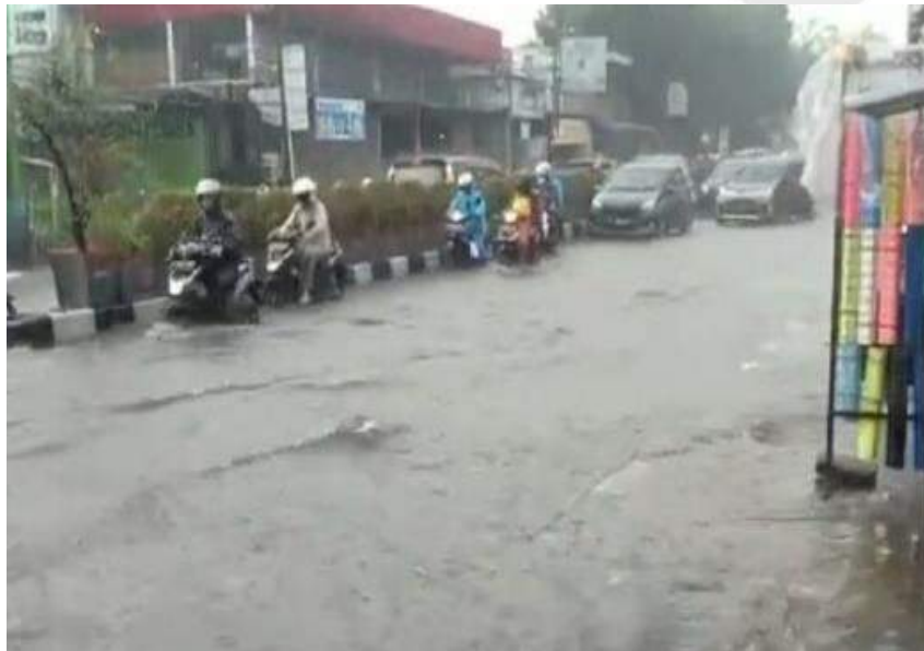
Gambar 2.50 Kondisi Saluran Drainase di Kota Cimahi
