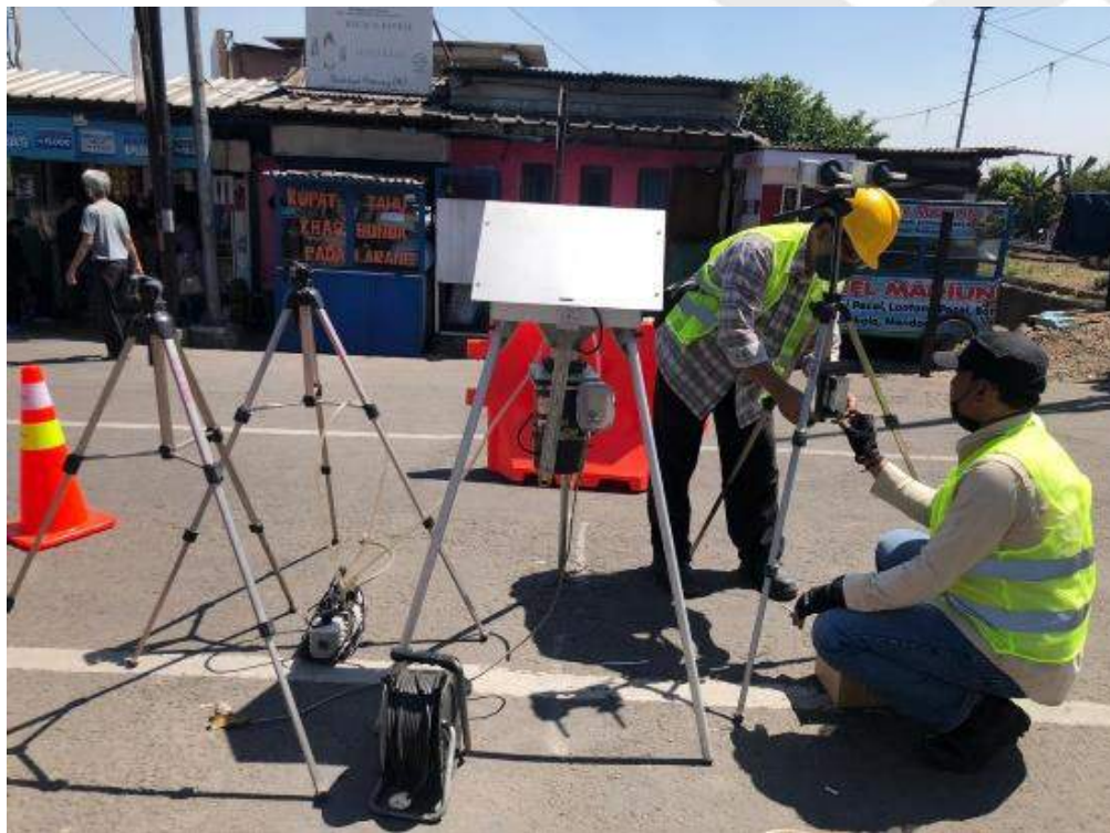
Gambar 4. 44 Proses Perencanaan Pembangunan Underpass Sriwijaya
